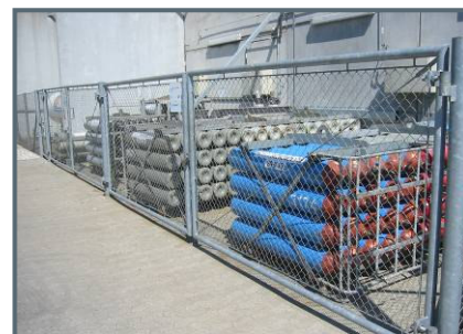
Brintlager ved Sintex A/S
