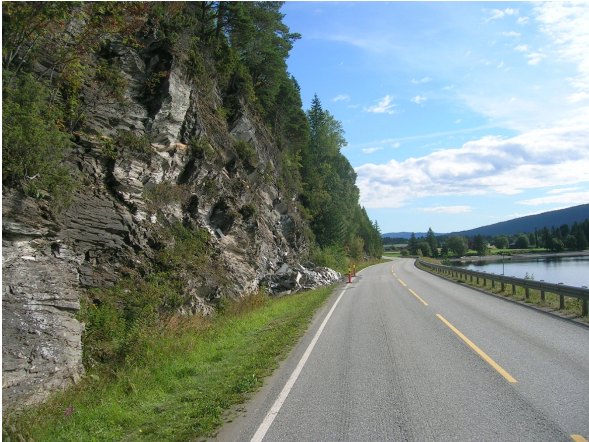
Bilde 2: Steinskred, HP4 km ca. 13,9 sett mot nordøst
