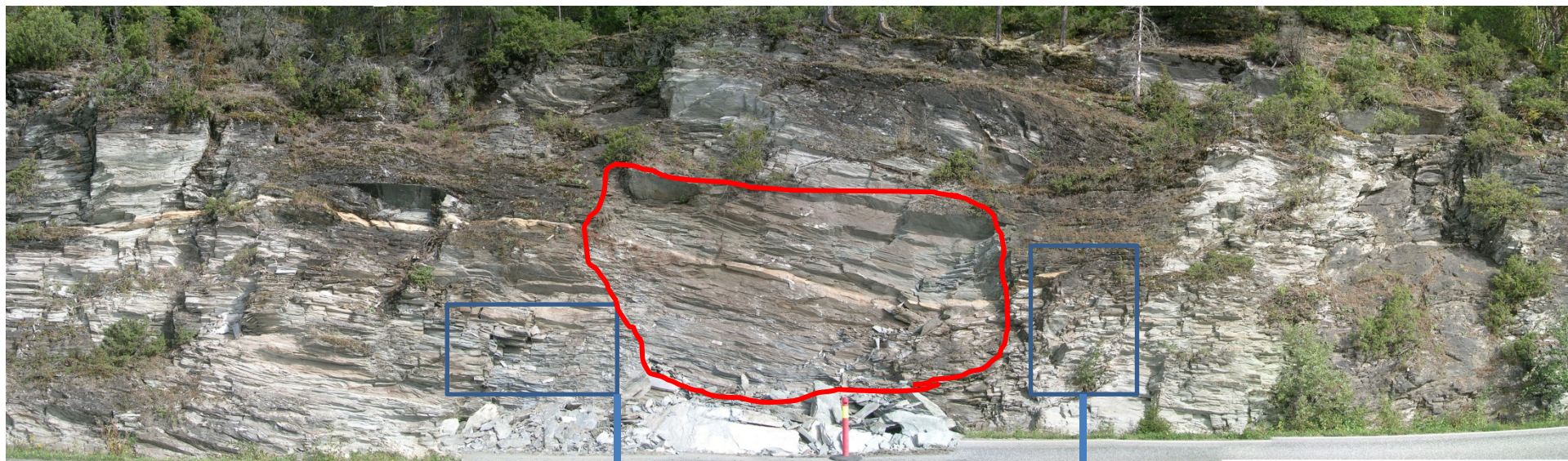
Bilde 1: Oversikt skjæringa, HP 4 km ca. 13,9 sett mot nordvest (løsn. området markert med rød linje)
