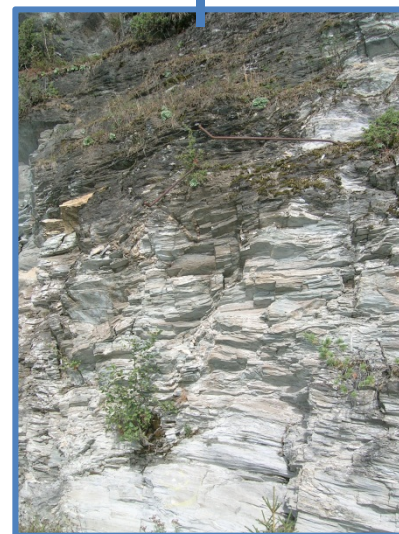
Bilde 1.2: Gamle sikringsbolter i berg
