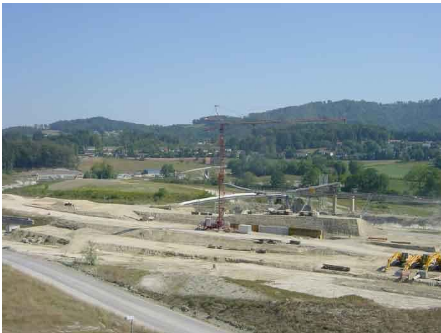
Bild 10. Autobahnbaustelle in Fildern (Birmensdorf)
