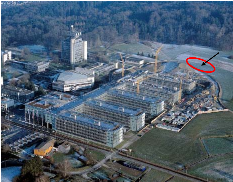
Bild 13. ETH Hönggerberg (Bau der neuen Chemiegebäude)
